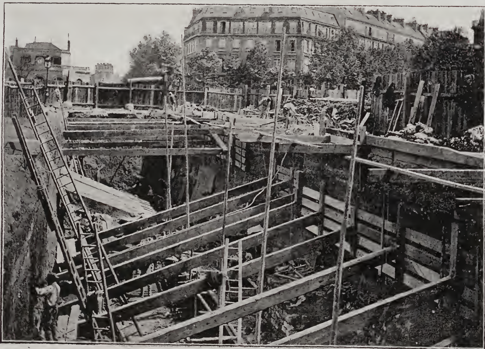
LA LIGNE COURCELLES-CHAMP-DE-MARS. — Chantier de la place Pereire (tête Auteuil, 1 re phase).
